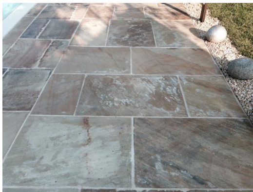
Pietra Indiana non trattata dove a causa del passaggio di acqua si è sviluppato un eccesso di sali cristallizzati in superficie
