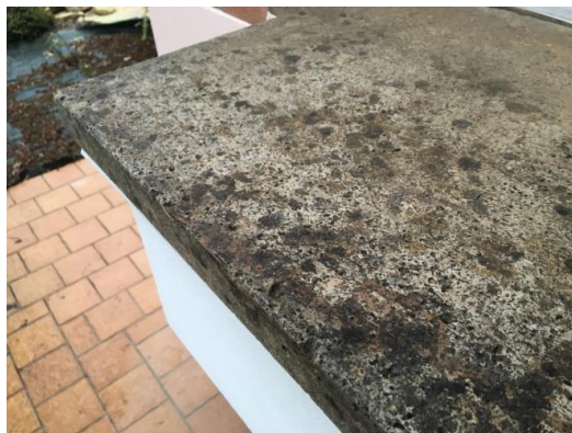
Trachite Euganea non trattata attaccata da microorganismi che ne hanno minato la struttura (in questo caso occorre addirittura levigare)
